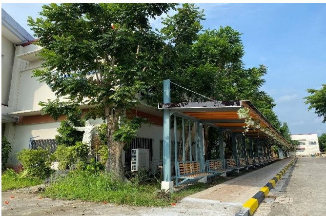
中学校校舎屋根付き通路の新設
